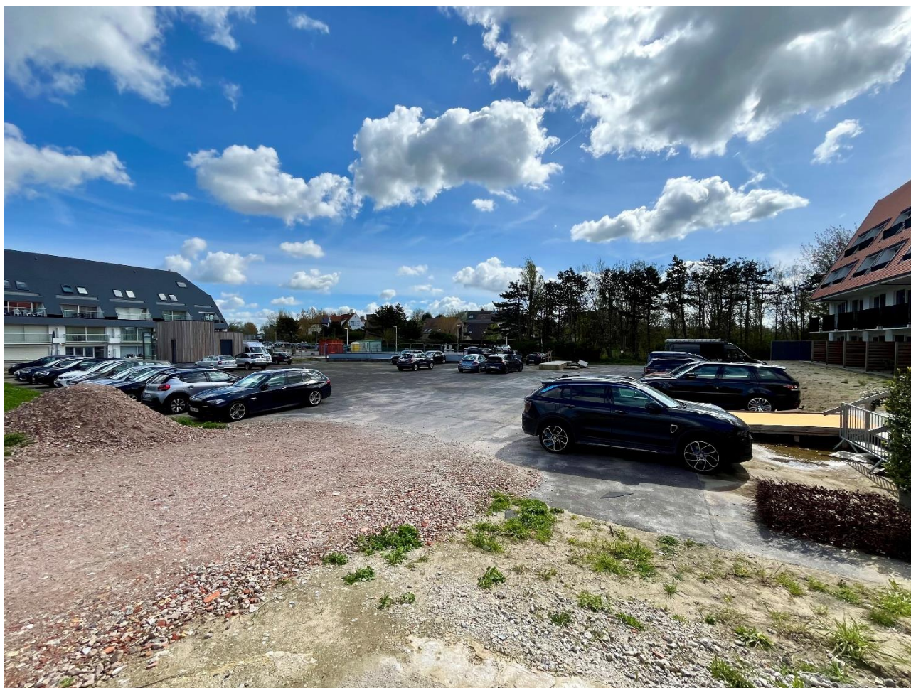
Vanaf maandag 15 april 2024 gaat de heraanleg van het Nieuwlandplein van start. (© Stad Nieuwpoort)
